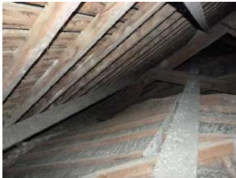
Planche instable, juste posée, servant de chemin de visite
