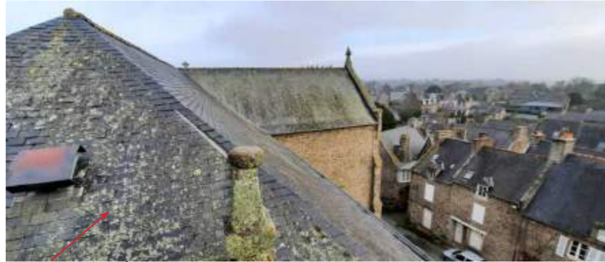
La toiture de la nef
