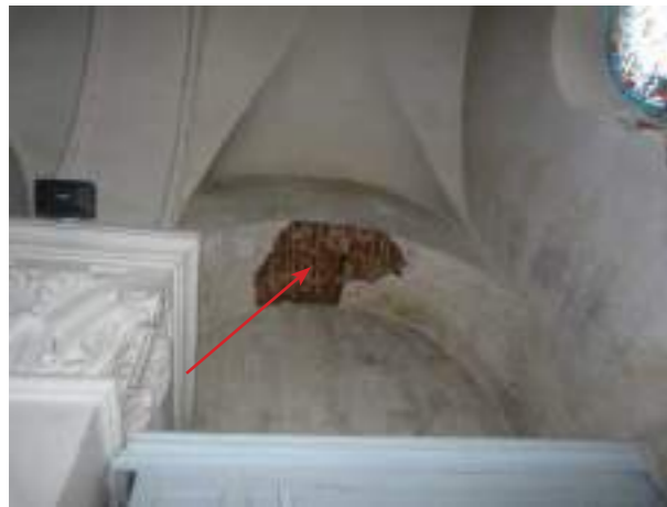
Bas-côté nord-ouest au-dessus du placard
