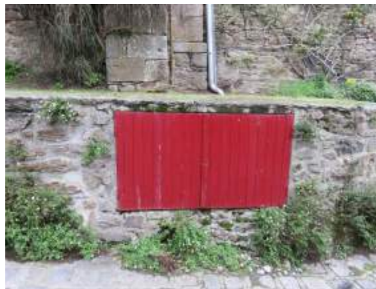
L'accès à l'installation gaz situé au sud de l'église
