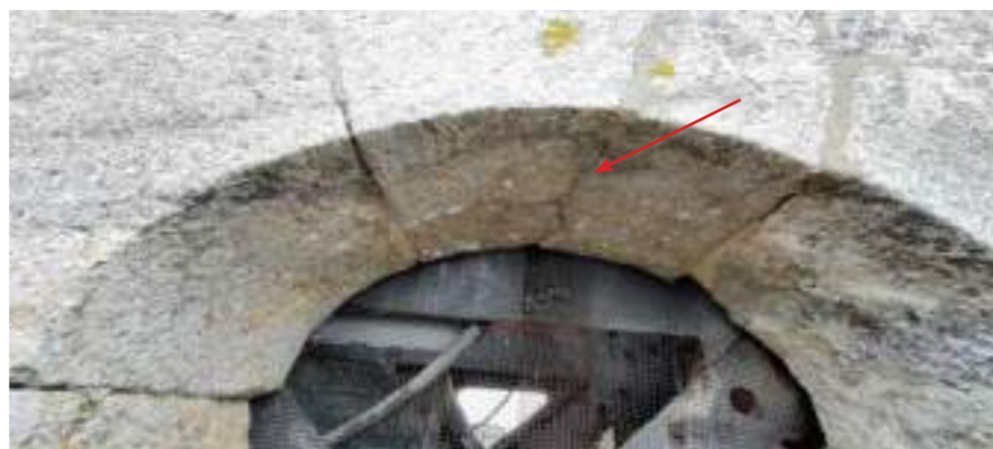
Le côté sud du clocher
