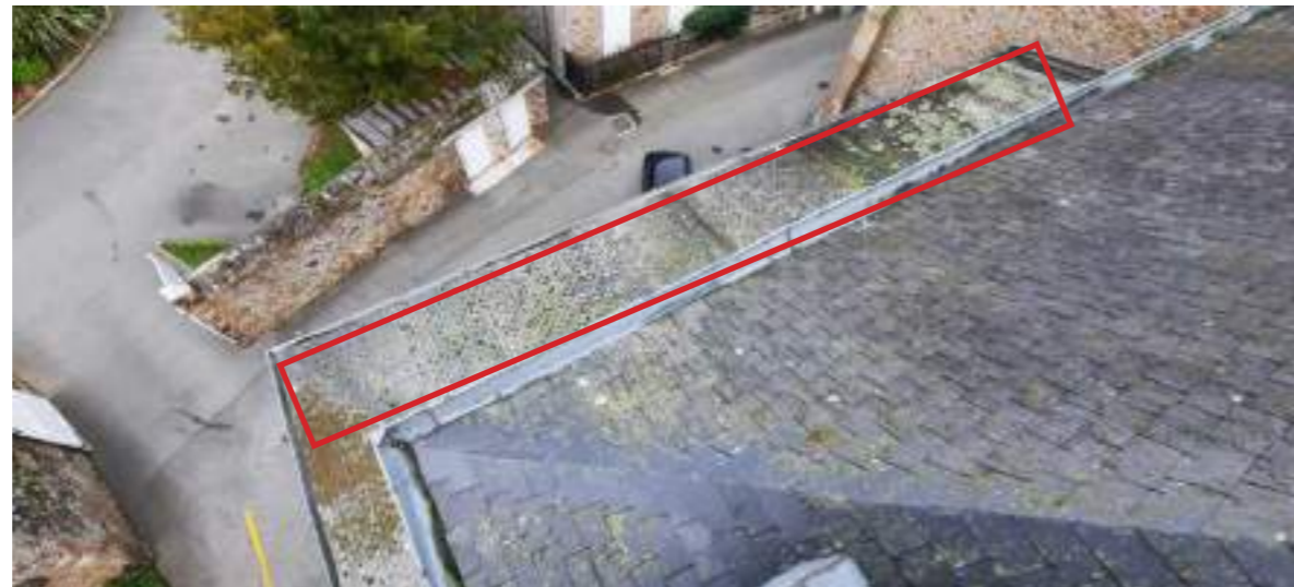
La toiture du bas-côté nord
