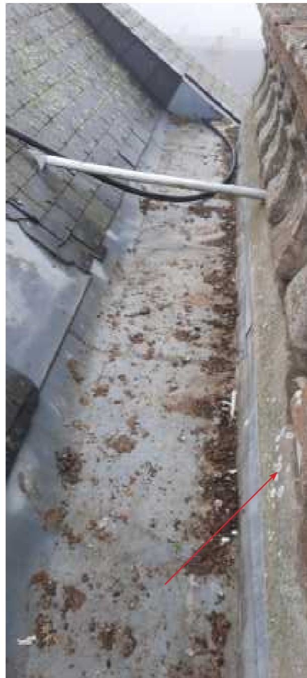
Mortier posé pour le relevé d'étanchéité du chéneau
